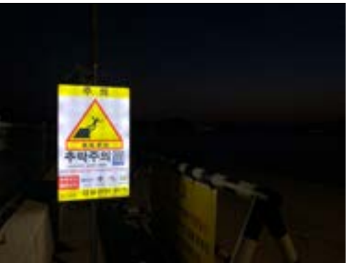
보완 안내판 태양열을 이용한 LED안내판으로 시인성과 치 효율을 극대화
